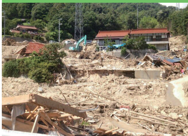
泥とがれきの流入で甚大な被害を受けた呉市安浦地区
