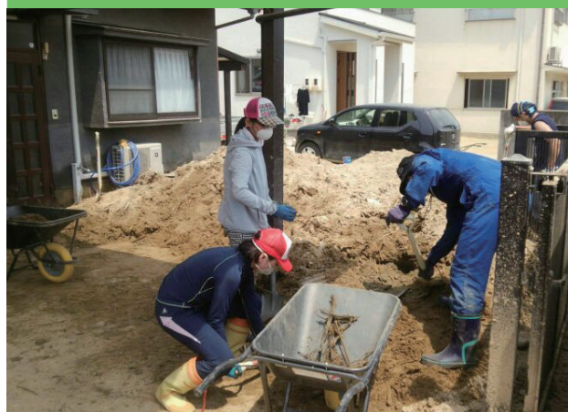
ボランティアによる被災した民家からの泥の撤去
