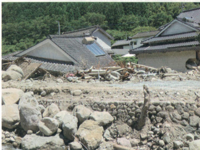
東峰村内の被害を受けた住宅と大量のがれき
